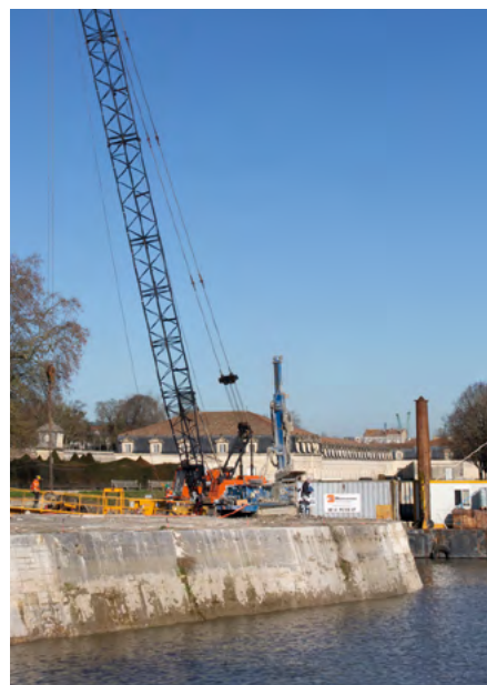
Un chantier hors normes de 3 millions € qui s'achèvera en avril.
