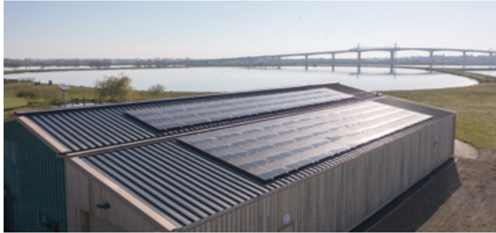
Photovoltaïque et cogénération cohabitent à la station de lagunage
