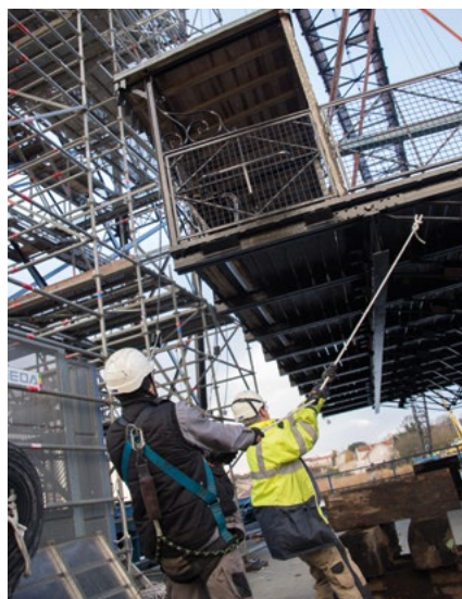
^ 28 novembre 2019 : le pont Transbordeur retrouve sa nacelle de 30 tonnes
